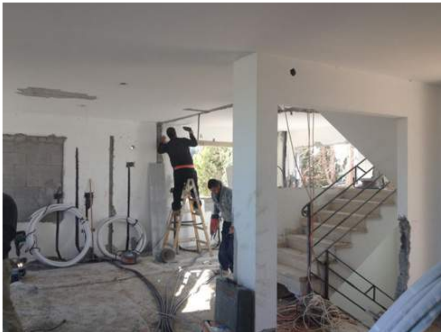
הבית במהלך השיפוץ. הותקנו חלונות גדולים, בוטלה החלוקה למפלסים ובוטל הקיר שהפריד בין מבואת הכניסה לגרם המדרגות
